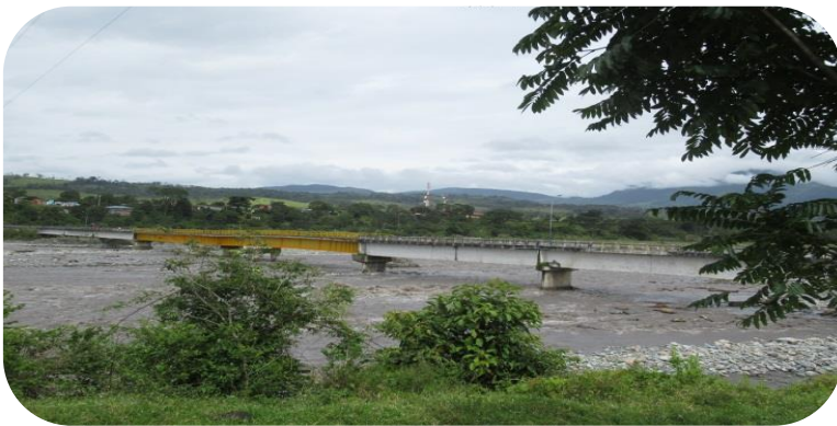
Puente de la Reconciliación sobre el río Guape, municipio de Lejanías, Meta (foto: Óscar A. Pabón M.)
